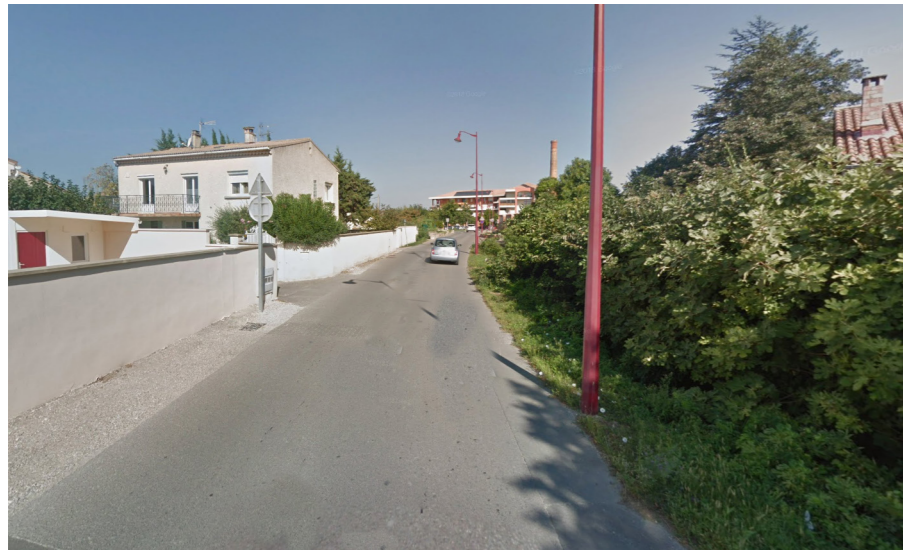
AVENUE DU 11 NOVEMBRE - EXISTANT
