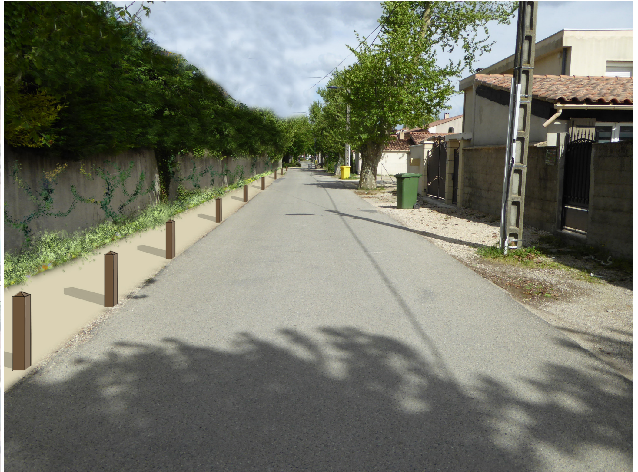
CHEMINEMENT LE LONG DU MUR DE CLÔTURE
